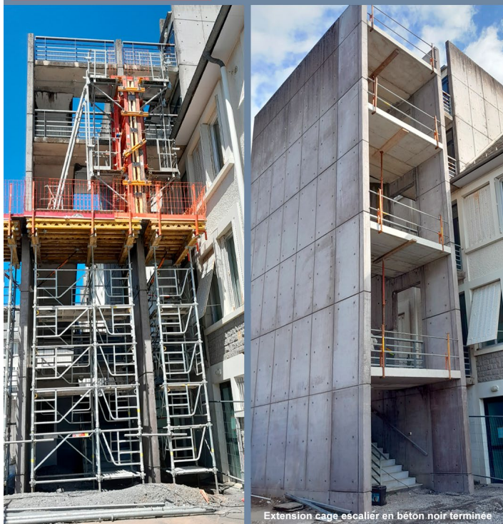
Extension cage escalier en béton noir terminée
